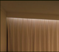
カーテンボックスには 間接照明を施しました
